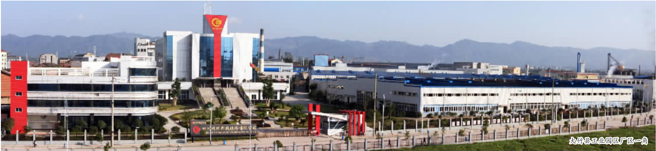
四川川环科技公司生产车间
