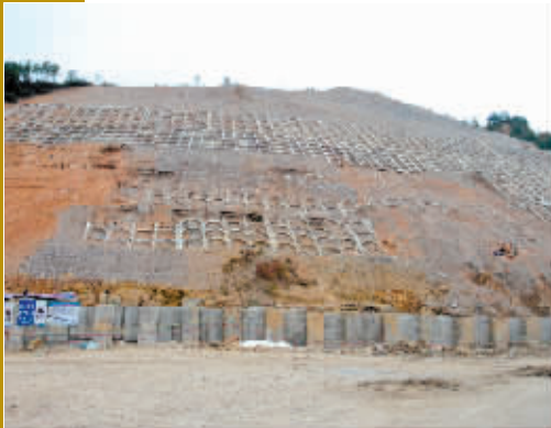
达陕高速公路万源互通大桥边坡治理
