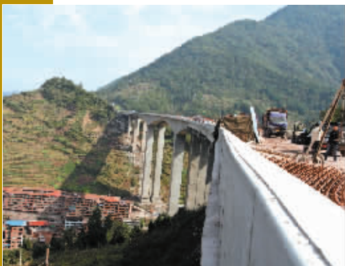
达陕高速公路宣汉厂溪特大桥
