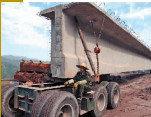
达陕高速公路宣汉境内采用现代化施工
