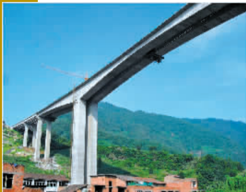
达陕高速公路厂溪特大桥中跨合龙
