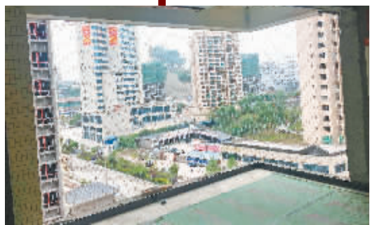
被拆除的窗户墙
