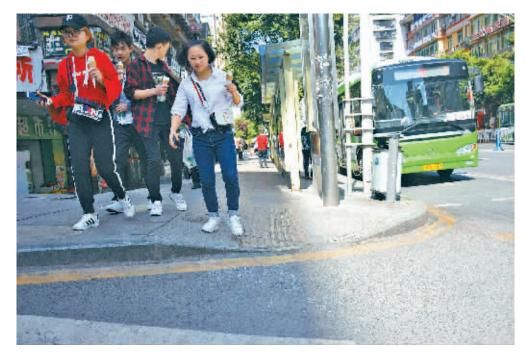
记者现场观察发现,人行路肩是用大理石砌筑 的,为方便轮椅进入盲道,盲道入口两端的大理石被 倾斜砌筑。记者体验, 左脚踩大理石右脚迈步, 右脚 刚离开地面,左脚就开始滑动,好在事先有心理防备 才没跌倒。记者注意到,如果被倾斜砌筑的大理石上 设有防滑凹槽,市民摔倒的可能性将大大降低。
