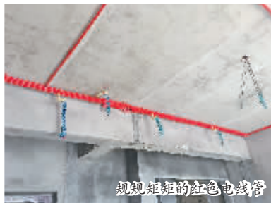
工人用卡子卡到接缝处
