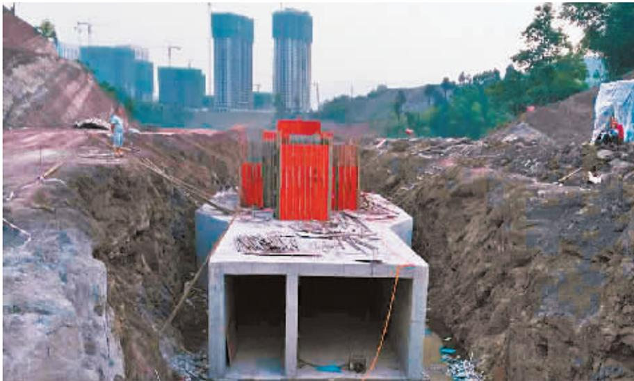
**本报讯** 伴随着凤凰山隧道西延线一期工程的开工建设,达州主城区首个真正意义上的地下综合管廊已经开建。该综合管廊全长1160米,设计断面为矩形(宽5.7米、高3.2米),空间一分为二,左侧为“燃气舱”,专供输气和配气,右侧为管道舱,作为电力、通信、给水等综合管道。
