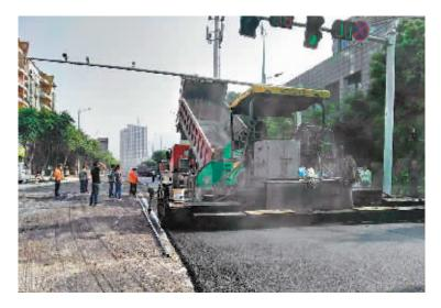
本报讯 "五一"期间,达城西外第 人民医院十字路口,几台大型沥青铺 装机器日夜开动。机器开过,原本光秃 秃的灰色水泥路面,立马变成冒着热气 的黑色沥青路面。此次金兰路病害整 治工程, 市政部门借鉴了国内外沥青 路面的成功做法,并结合我市具体情 况,在达州首次尝试采用玄武岩沥青面
