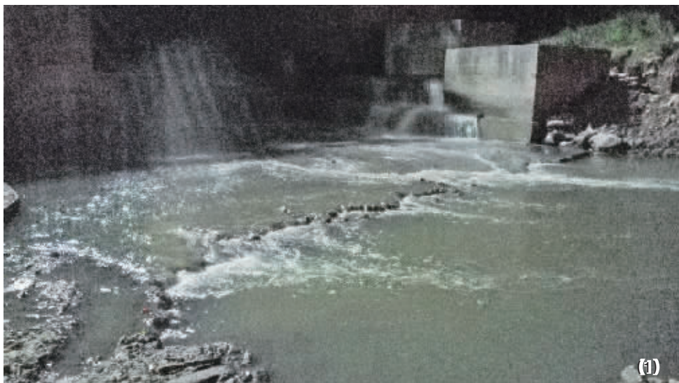
现场:大量污水排入河中
