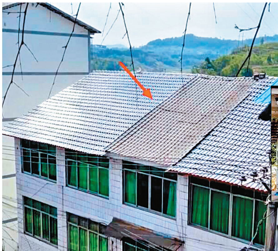
▲施工单位用的树脂瓦单片面积较大。(受访者供图)
