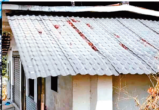
▲施工单位用的树脂瓦单片面积较大。(受访者供图)
