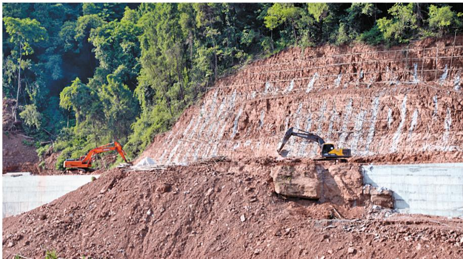
近日,记者来到位于通川区凤北街道双河口水库的双鱼湖环湖路建设项目现场看到,搅拌机、挖机在工地上来回穿梭,工人们正在进行路基土方开挖、精平回填及路基内外挡墙施工。截至目前,该项目已完成总工程量的60%,预计12月25日前完成竣工验收,12月底有望全线通车。
