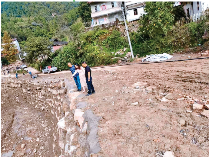
大竹县庙坝镇长乐村纪委书记赵秋兰对灾后重建工程建设情况进行监督检查。
