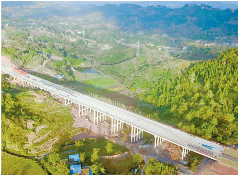
据了解,铁山连接线是营达高速公路项目的重要组成部分,线路起于营达高速铁山互通,向北与河市西片区控规规划的南北干线线位重合,至汇通大道西延线,止于已建的河市大道,全长约6公里。项目区间内设有桥梁、路基、涵洞,路基宽32米,双向六车道,设计速度60千米/小时,预计总投资8.0928亿元。
