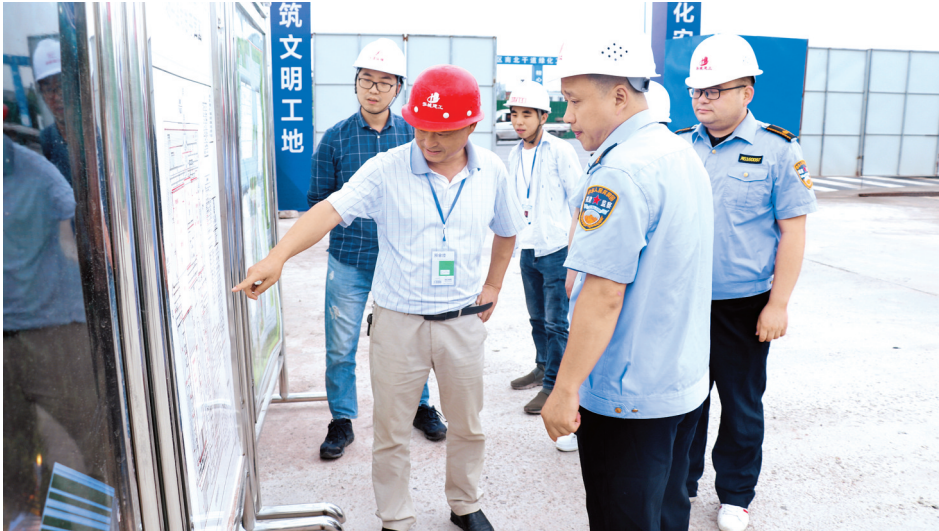
市发改委与市住建局相关工作人员在达州传媒中心建设项目(一期)工地督查。
