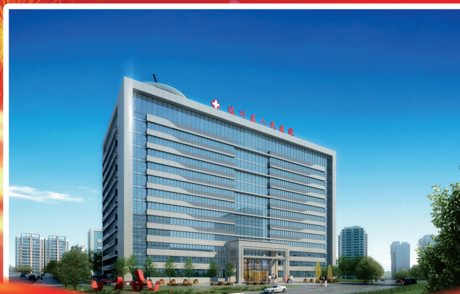
正在建设中的新内科大楼
