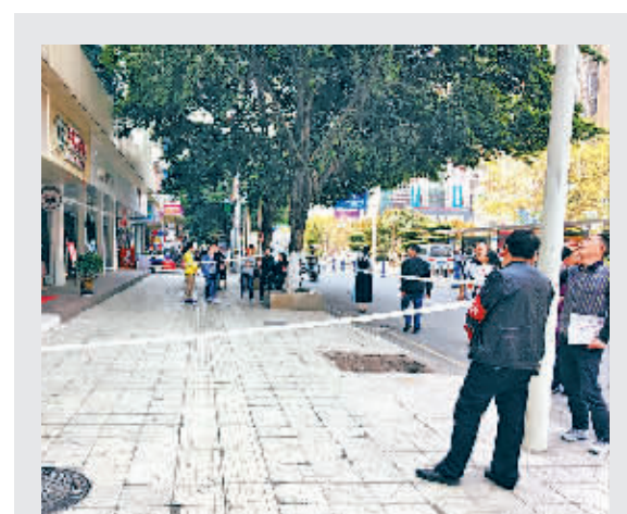
通川区东城街道办事处文华街社区来凤路一居民楼外墙上的空调架在4月5日被风刮松,随时可能掉落到人行道上,危及过往行人的安全。10日上午,文华街社区工作人员在楼下拉好警戒线为居民排危,消除了这一安全隐患。(郎家 摄)
