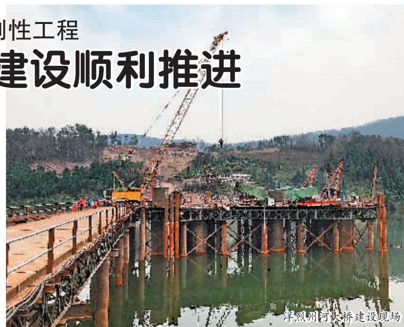
洋烈州河大桥建设现场
