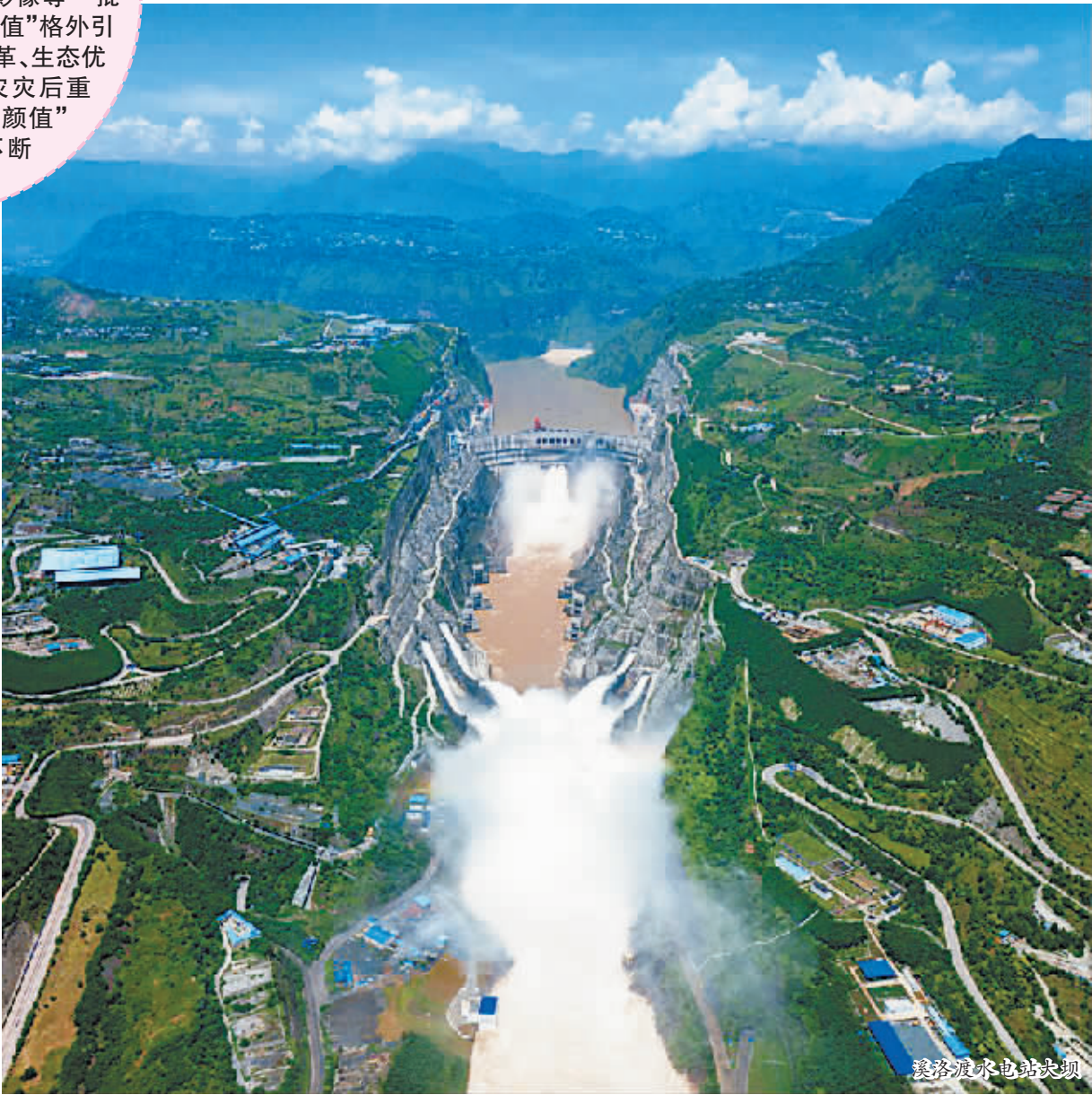
溪洛渡水电站
