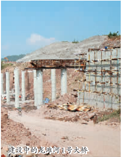
建设中的龙潭河1号大桥
