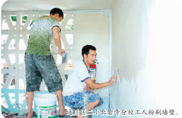
通川区二小北岩寺分校工人粉刷墙壁。
