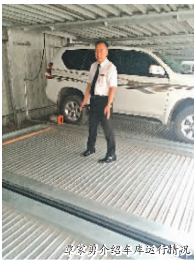
覃家勇介绍车库运行情况
