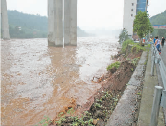
通川区罗江口大桥上游L型河段因河水冲刷形成冲滩，给宣罗公路带来地灾隐患。
