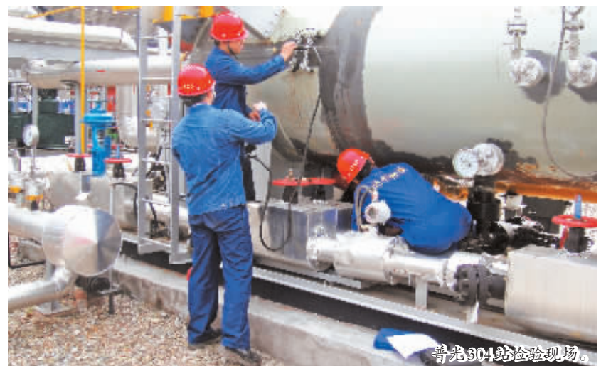
普光304站检验现场。
