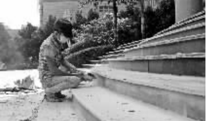
工人在维修教学楼台阶。(本报记者 桂爽 摄于达州市第一中学)
