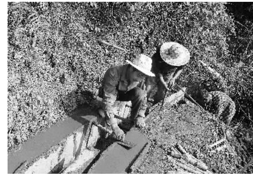
宣汉县南坝镇自力更生，不等不靠，积极组织群众修复“7·4”洪灾损毁的塘、堰等水利工程31处。图为该镇高墩村村民顶着烈日抢修瓦厂湾水库水渠。
