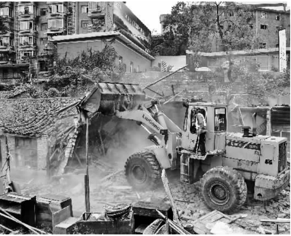
居民纷纷表示:“两处破漏的违法建设,有损城市形象,拆得好!” (王学伟 本报记者 谭楚甲 摄影报道)
