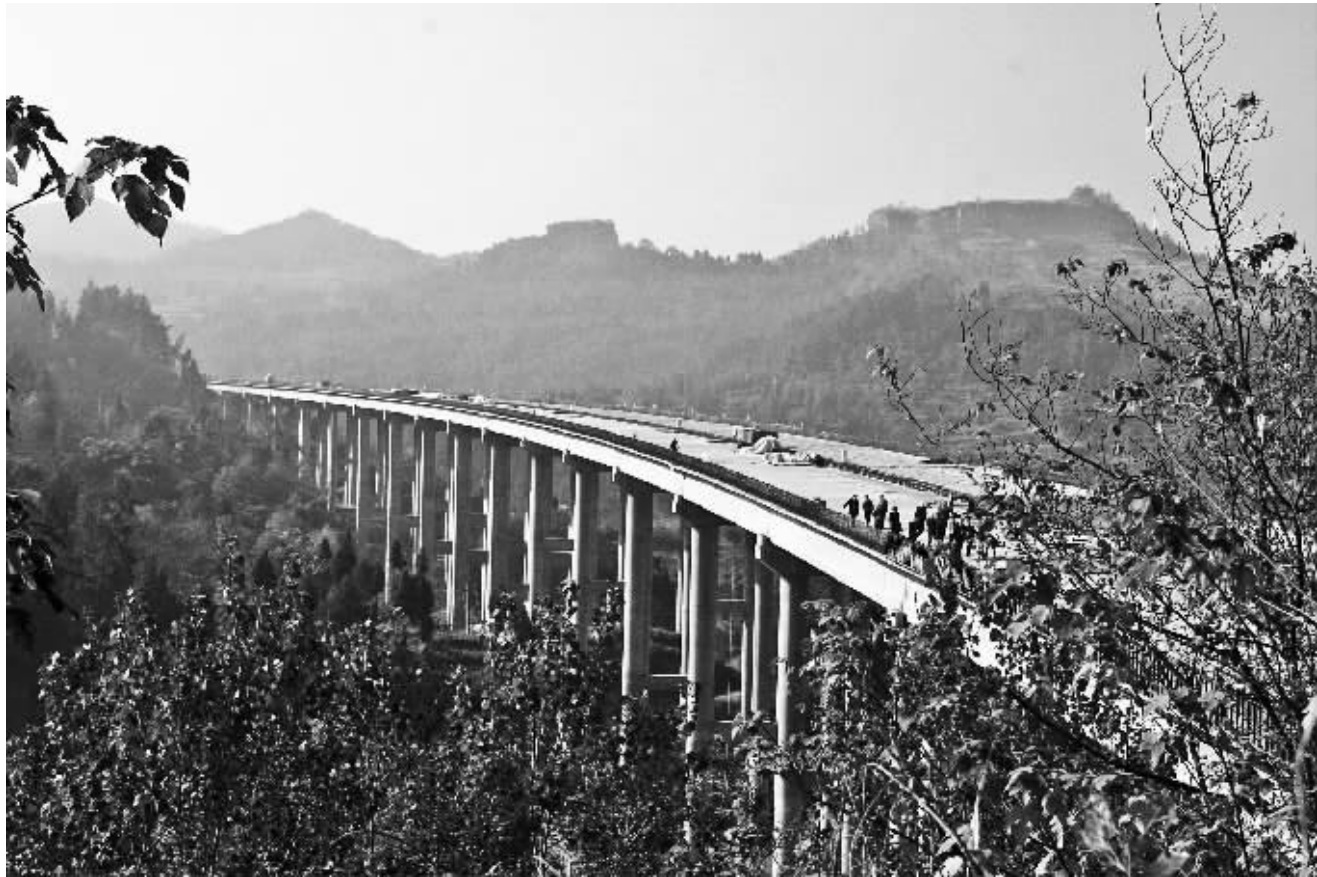
达陕高速公路达州段地形地质复杂,桥隧众多,桥梁多达 194 座,隧道多达 27 座。广大建设者克服困难,科学施工,目前工程进展顺利。图为即将建成的桥长 1449 米的方斗村特大桥。( 何其伦 摄 )
