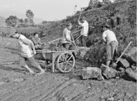
在今年“7·18”特大洪灾中,宣汉县清溪镇白鹤村白树沟滑坡体造成17户村民房屋全垮。在当地党委、政府的帮助下,目前已有12户购房安置,其余5户正在修建新房。图为受灾户胡纯益正在新址上平整地基。
