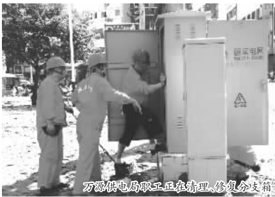
万源供电局职工正在清理、修复分变箱
