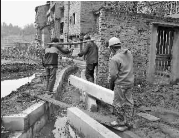
建设优美乡镇, 环境保护先行。今年, 宣汉县君塘镇投入资金 60 余万元在场镇修建排污管道 1200 多米, 实现雨污分流, 解决了老场镇 420 户居民生活污水、废水直排问题。图为施工现场。 (王梦 摄)
