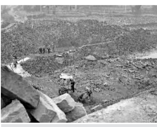
大竹县筹资130余万元,把黄滩乡至团坝镇的渡口改建为公路桥。11月动工以来,工程进度顺利,预计2010年4月竣工。届时两岸7000余人将告别渡船,出行更为方便。图为施工现场。(薛友明 摄)
