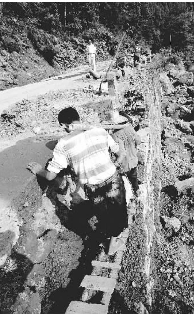
连日来，在宣汉县遭受洪水重创的乡镇，广大干部群众不等不靠，全力抢修水毁的基础设施。图为白马乡干部群众在抢修河堤。（漆楚良 陈伟 本报记者 张崇耀 周本均 摄）
