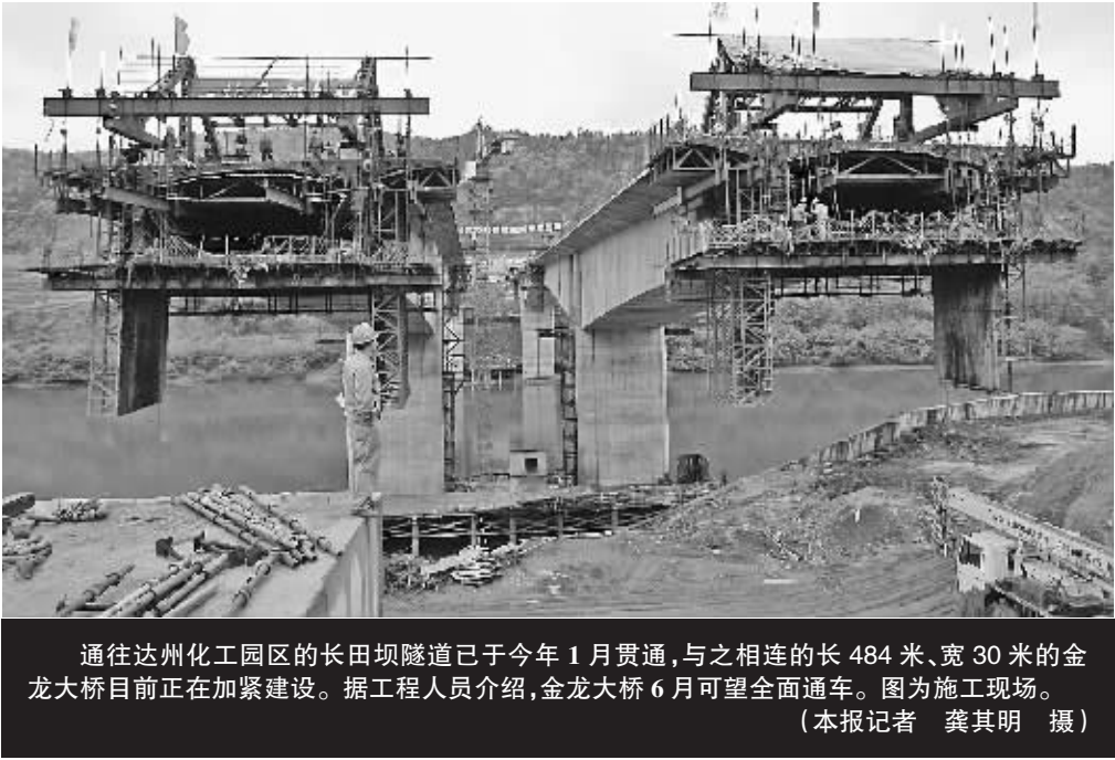
通往达州化工园区的长田坝隧道已于今年 1 月贯通,与之相连的长 484 米、宽 30 米的金龙大桥目前正在加紧建设。据工程人员介绍,金龙大桥 6 月可望全面通车。图为施工现场。(本报记者 龚其明 摄)
