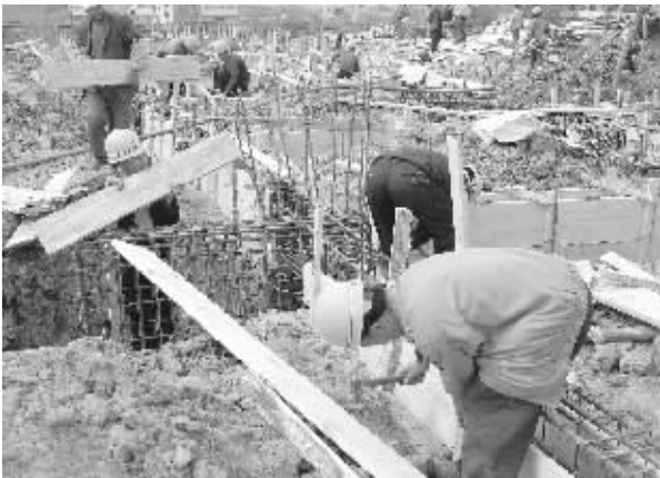
大竹县着力抓好廉租房和经济适用房建设,切实解决城镇低收入家庭住房困难。图为莲沱社区“两房”建设工地的工人正在给地圈梁装木盒子。
