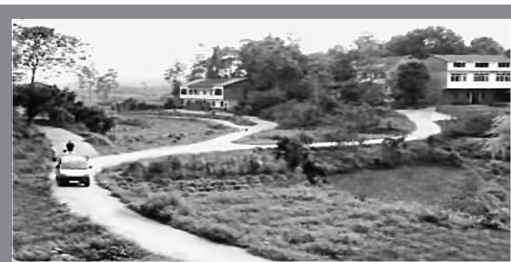
大竹县庙坝镇寨峰村先后募集到近 100 万元的爱心善款，短短两年时间，修通了连接 8 个村民小组的 8 公里长、宽 3.5 米的水泥公路。图为寨峰村环村水泥路一角。（本报记者 王晓林 摄）
