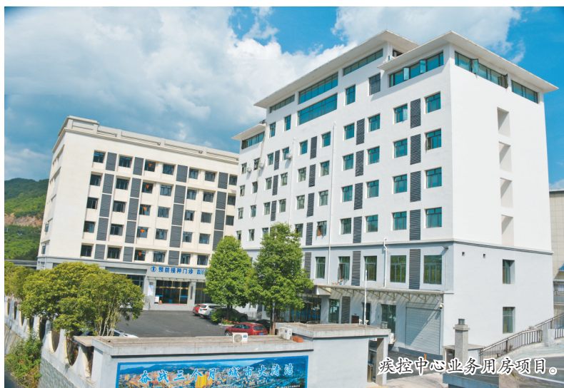
万源市医疗综合业务用房大楼。
