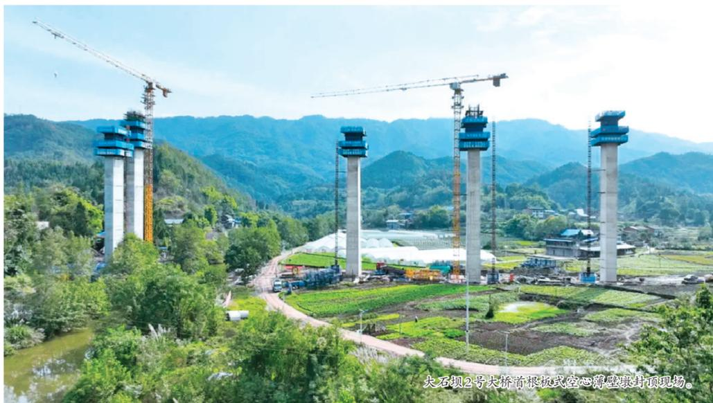
大石坝2号大桥首根板式空心薄壁墩封顶现场。
