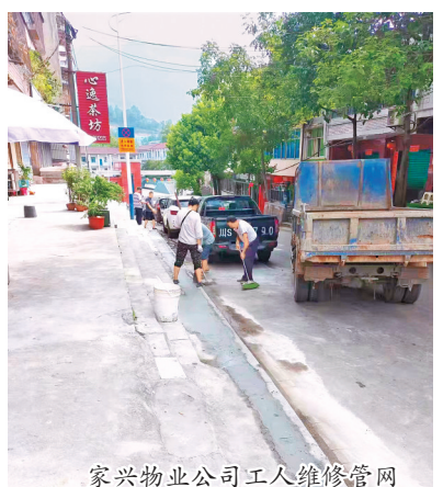
家兴物业公司工人维修管网
