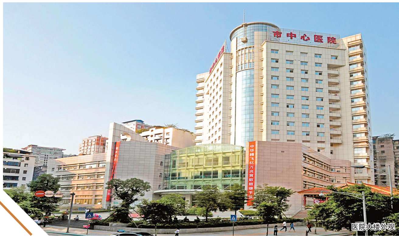
医院大楼外观
