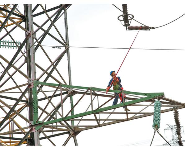
5月19日,国网达州供电公司220千伏复盖线开展集中停电检修作业,保障电网迎峰度夏可靠供电。图为该公司员工在1号塔架装接地线前进行验电。(王鸿基 摄)
