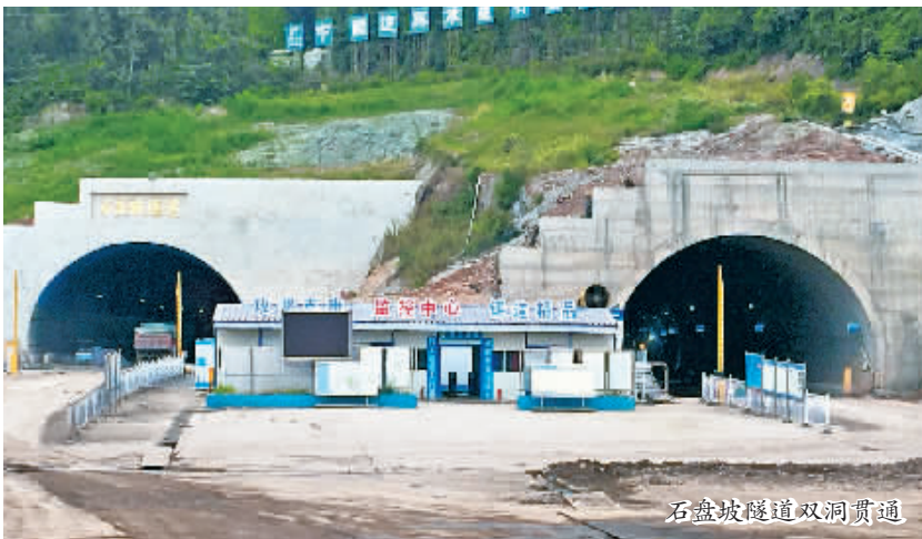
石盘坡隧道双向贯通
